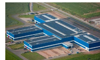
Gonvarri, Erfurt Leistung: 563 kWp Inbetriebnahme: 10/2006
