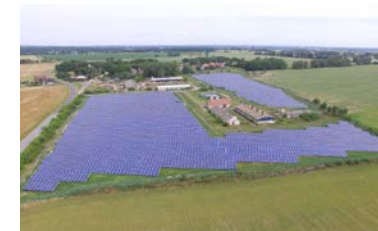
Bliesdorf Leistung: 13.000 kWp Inbetriebnahme: 05/2017
