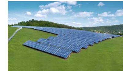
Olovary Leistung: 1.994 kWp Inbetriebnahme: 02/2011
