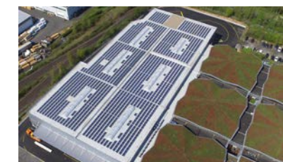
Hübner, Kassel Leistung: 378 kWp Inbetriebnahme: 04/2018
